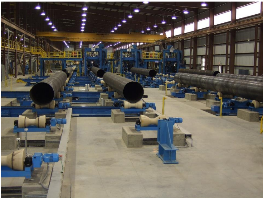
Links im Bild: Der Freiplatz für den vierten Nachschweißstand im Spiralrohrwerk der Stupp Corporation.
